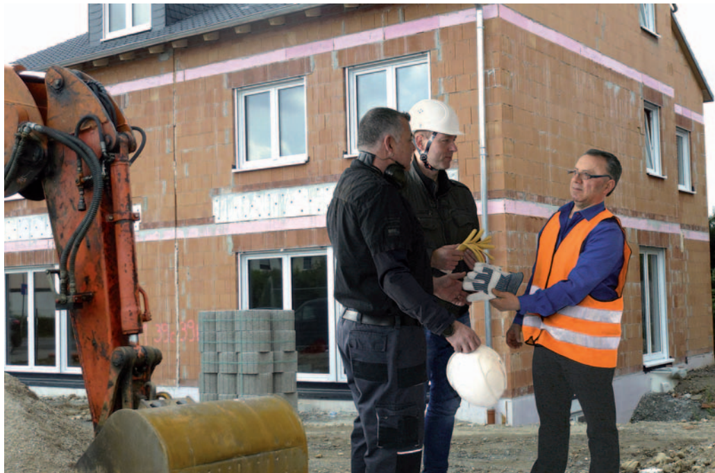
Private Bauherren sollten sich in Sachen Arbeitsschutz umfassend durch die BG BAU beraten lassen.
