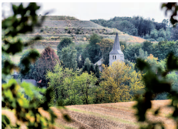
Der Wetterhahn musste abgenommen werden, bald sollen die Sanierungsarbeiten am Turm beginnen.
