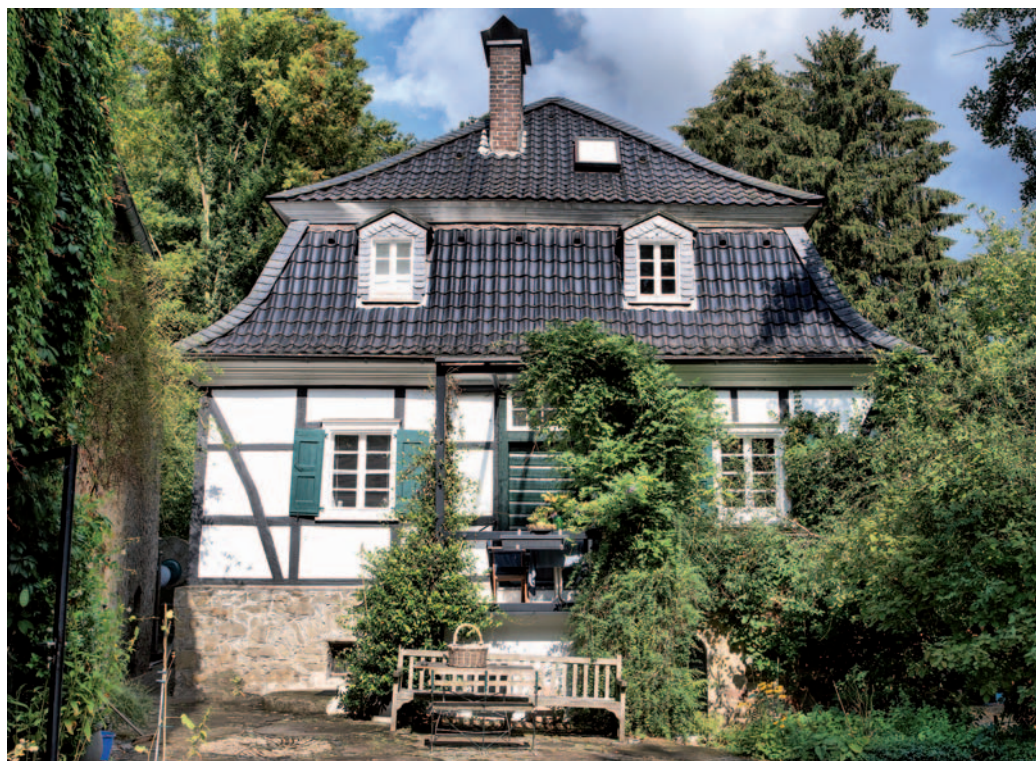
Die Bausmühle steht unter Denkmalschutz. Dafür haben die Eigentümer selbst gesorgt.
