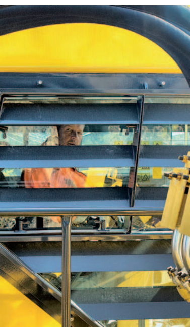
Der Baggerführer des PC 4000 ist umgeben von moderner Technik.
