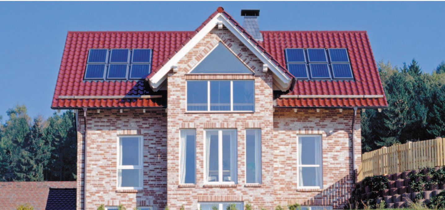
Ob Solarthermie oder Fotovoltaik – mit einer Solaranlage auf dem Dach lässt sich kostenlos Strom und Wärme gewinnen.
