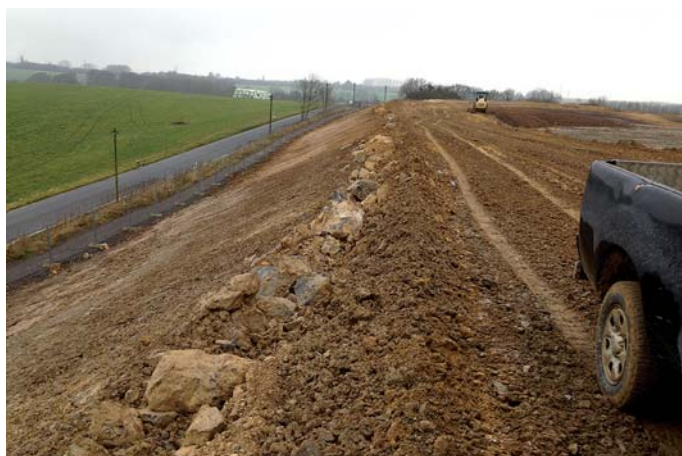
Seit Wochen rollen am Schöllerweg zwischen Gruiten und Schöller die Bagger, um den ersten Wall für die neue Halde aufzuschütten.
