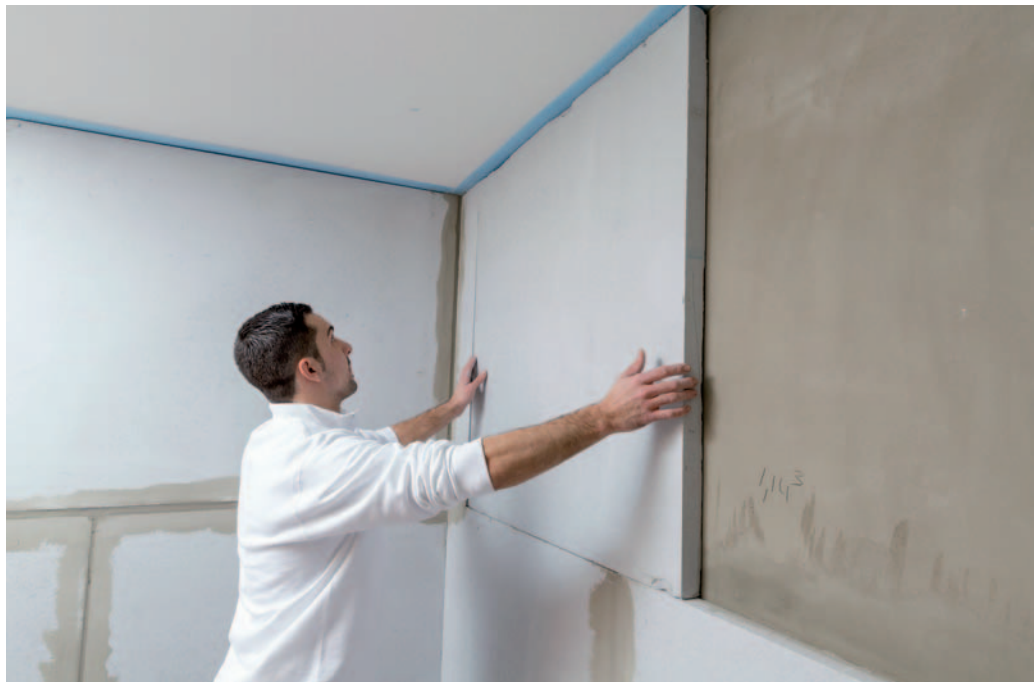
Gegen Kondensatprobleme helfen Klimaplatten.
