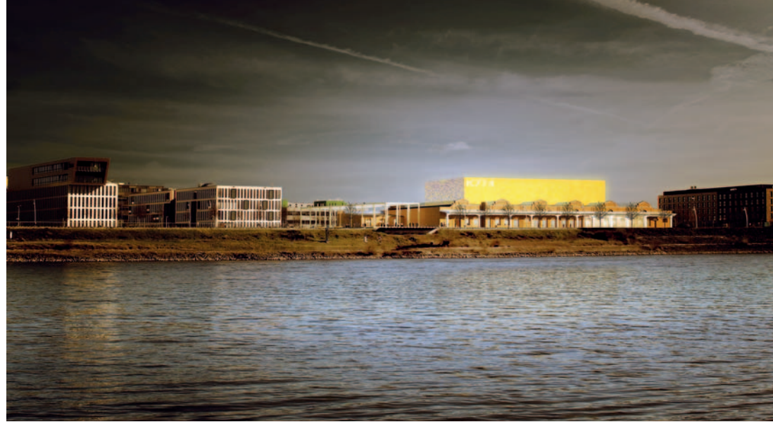
An der Monheimer Rheinpromenade wird die alte Shell-Fassabfüllanlage zu einer modernen, multifunktionalen Veranstaltungshalle umgebaut. Sie wird den Namen Kulturraffinerie K714 tragen.
