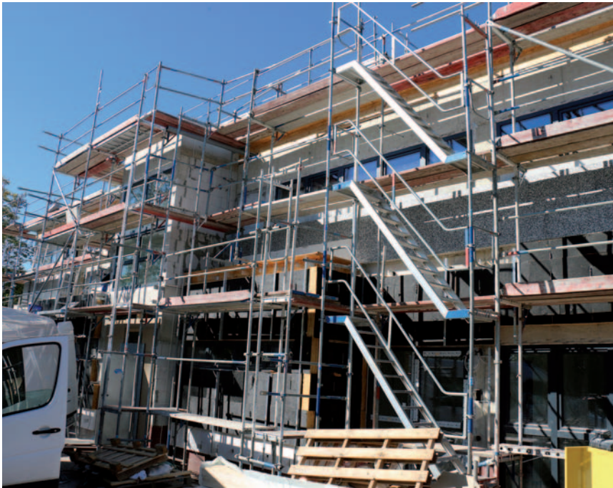
Während drinnen noch eifrig gebaut wird, steht die Fassade weitestgehend.
