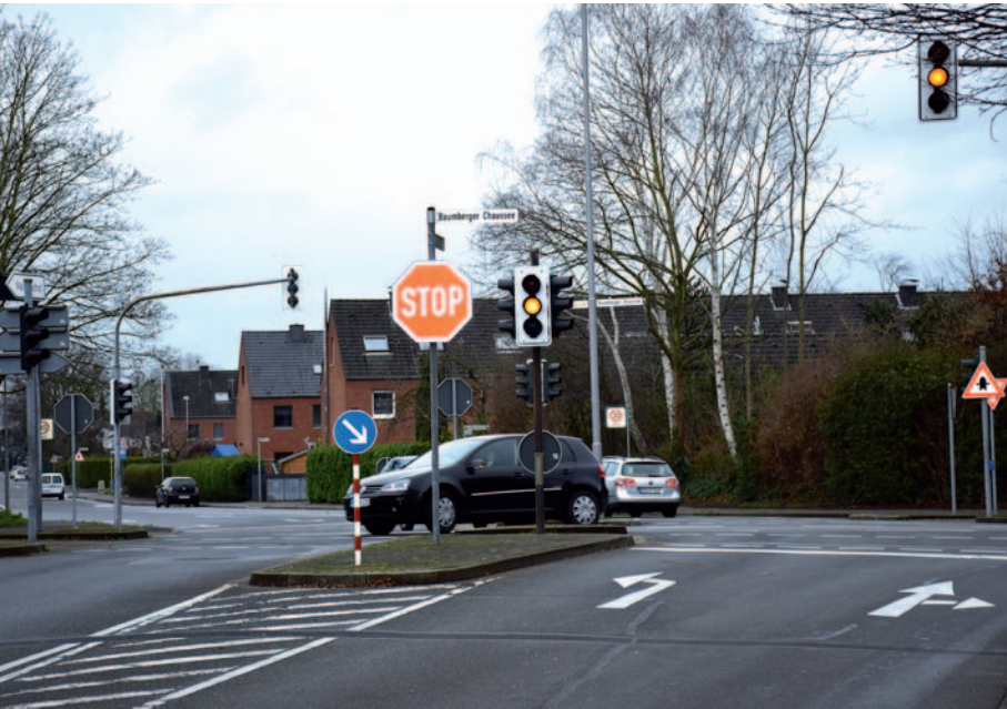
Blick aus der Marderstraße: Der geplante Kreisverkehr macht den Verkehr nicht nur flüssiger, sondern die Ampelanlage wird nicht mehr gebraucht. Foto: Norbert Jakobs
