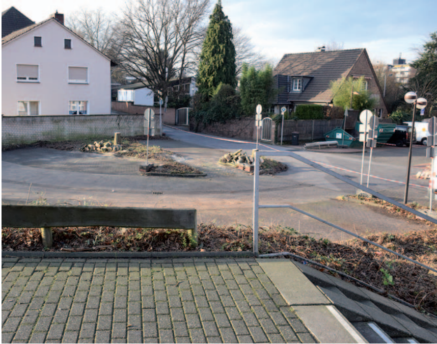
Nach einigen Rodungen am Berliner Ring in Richtung Friedhofstraße beginnen im Januar die eigentlichen Arbeiten für die Rampe. Foto: Norbert Jakobs
