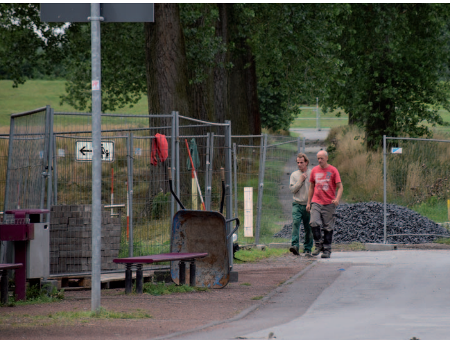
Die Arbeiten für den Landschaftspark Rheinbogen gegenüber der Altstadt haben begonnen.
