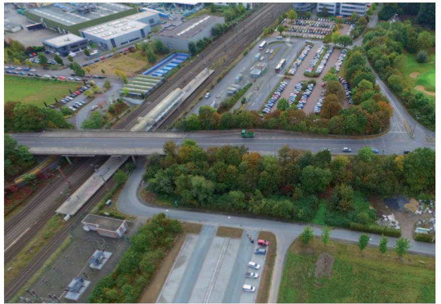
Blick von oben auf den neuen Parkplatz am S-Bahnhof.
