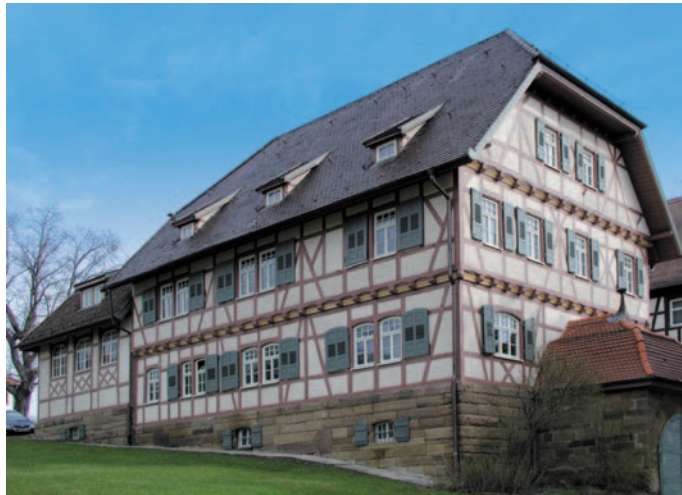
Altbausanierungen bergen auch Risiken, denn gefördert wird nur Geschütztes und Schützenswertes. Absetzbar ist nicht alles, was baurechtlich genehmigt ist. Foto: Remmers
