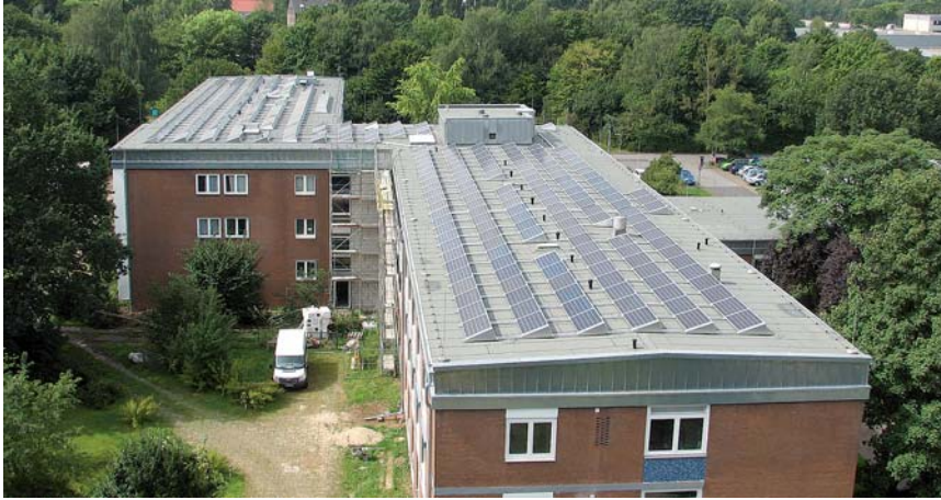
Die LVR-Klinik setzt auf Photovoltaik.
