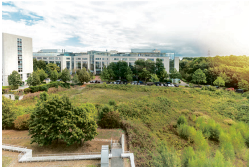
Blick auf das vorgesehene Grundstück.
