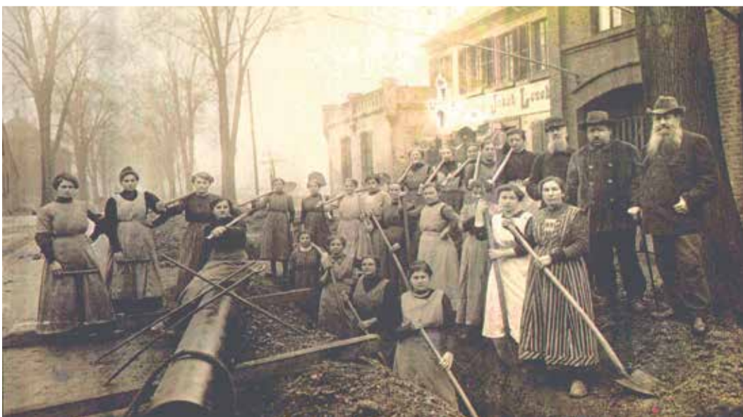
Bau der Wasserleitung nach Grimlinghausen an der Cölnerlandstraße (heute: Kölner Straße), um 1915
