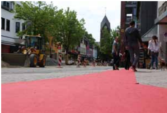
Auf der Baustelle Solinger Straße wird derzeit der rote Teppich für die Kundschaft ausgerollt. Foto: Andreas Voss
