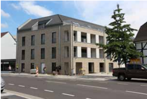
Auch das Neubauprojekt der Arbeiterwohlfahrt an der Solinger Straße steht kurz vor der Fertigstellung. In wenigen Tagen können dort bereits die ersten Wohnungen bezogen werden.
