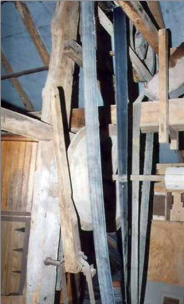
Bild 17: Obergeschoss: Transmission für Elevatoren (NiG11).
