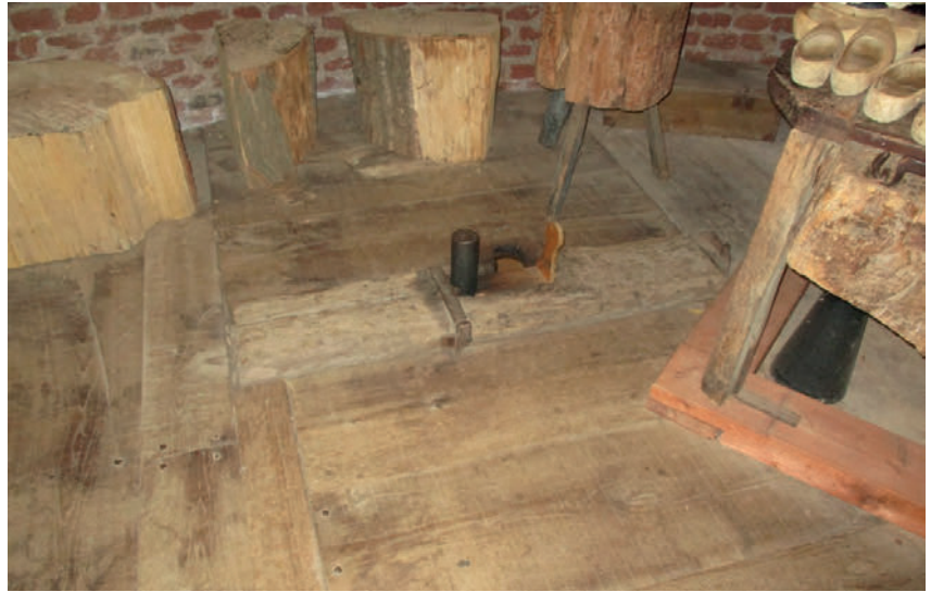
Oberes Lager des Mahlgangs Mw1.
