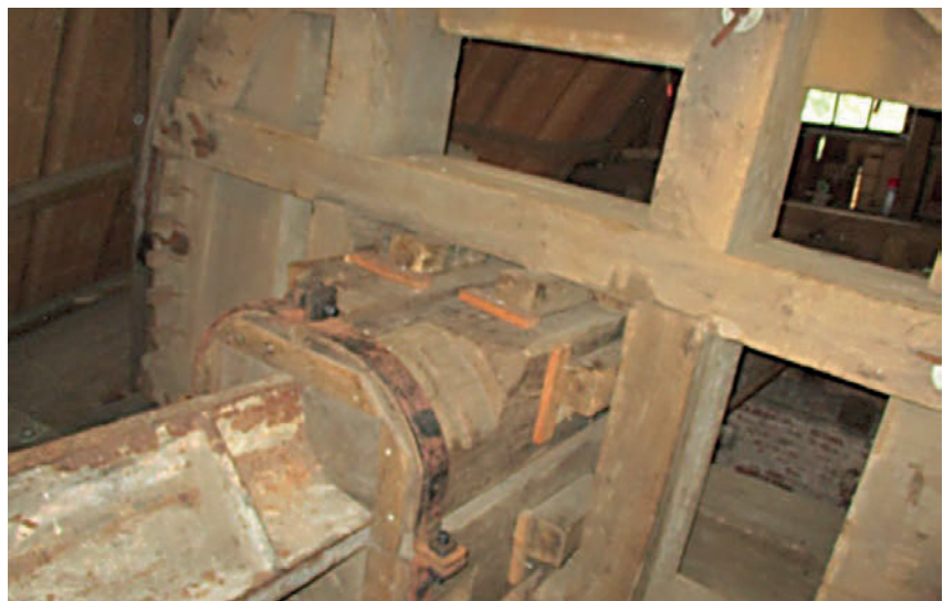
Rückseite des Kammrades mit dem Rest der ehemals hölzernen Flügelwelle, der heute zum Fixieren des Rades auf der eisernen Welle dient.
