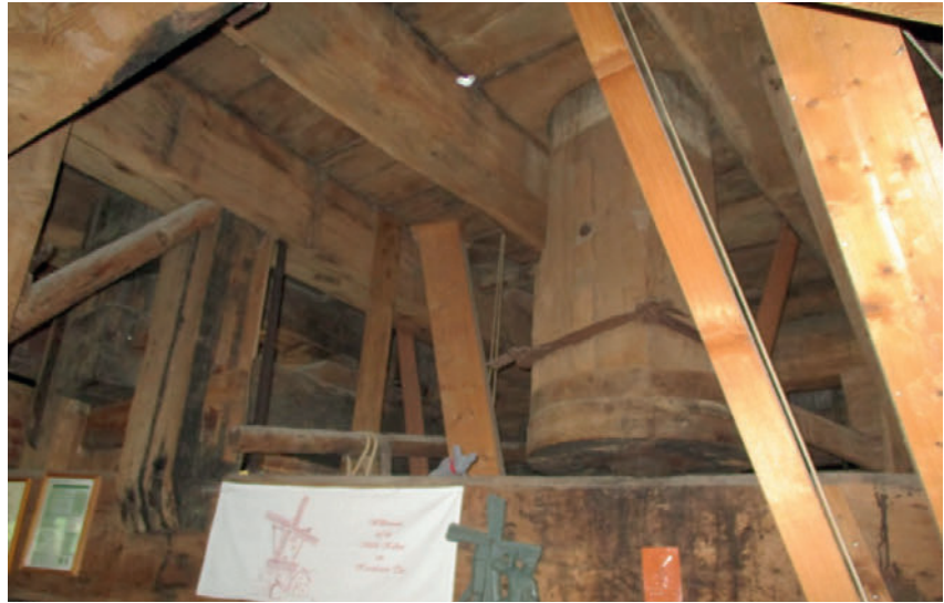
Fußlager der Königswelle Kw mit Riemenscheiben zum Antrieb der stehenden Welle W2 und des Mehl-Kühlapparates Ka.
