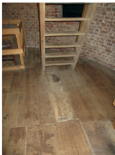
Oberes Lager des ehemaligen Mahlgangs Mw3.
