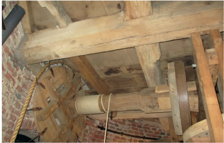
Sackaufzug A1 mit Laufrad für Wind- und Gaffelrad für Handbetrieb.
