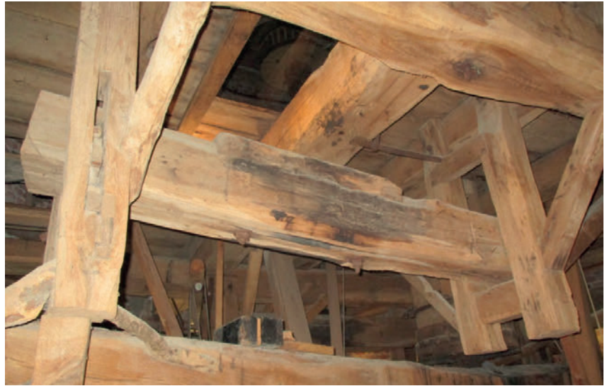
Lichtwerk zum ehemaligen Windmahlgang Mw3.
