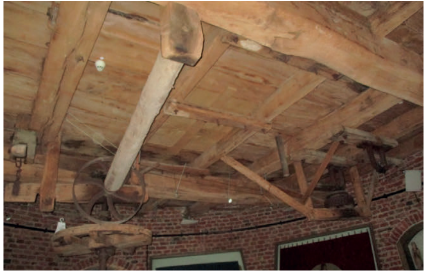
Sackaufzug 2 A2 für Wind- bzw. Motorantrieb, hinten rechts Vorgelege W2 zum Antrieb ehemaliger Transmissionswellen auf diesem Boden.
