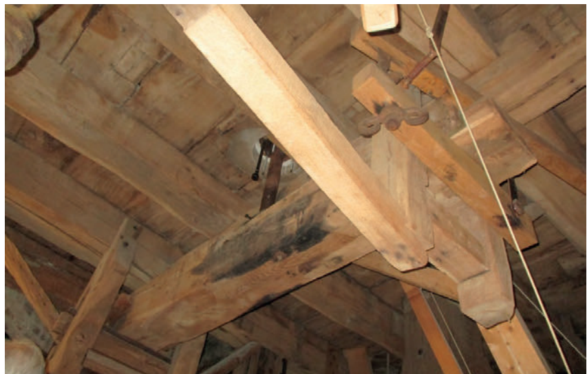
Lichtewerk des Windmahlgangs Mw1.
