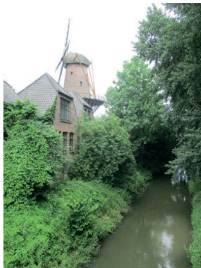
Bild links: Ansicht vom Stadtgraben/Leybach aus.
