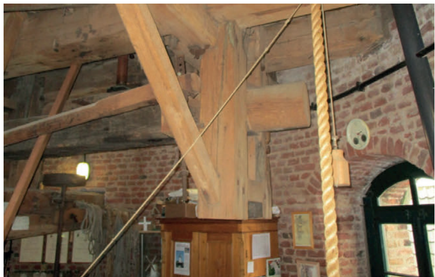
Lichtewerk des Windmahlgangs Mw2. Der Brückenbalken war ehemals eine hölzerne Spindel, wie am abgedrehten rechten Ende sowie dem Loch des Einsteckzapfens am linken Ende zu erkennen ist.
