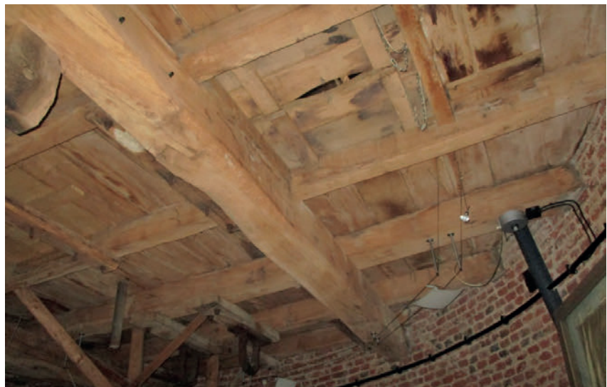
Luke L1 zum Sackaufzug A1, rechts daneben ehem. Schacht L3 für Sackaufzug A3.
