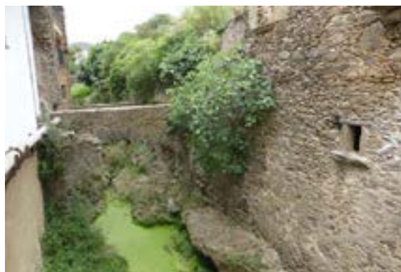
Blick von der Brücke auf den Riera de la Selva und die Mühle (rechts) in La Selva da Mar.
