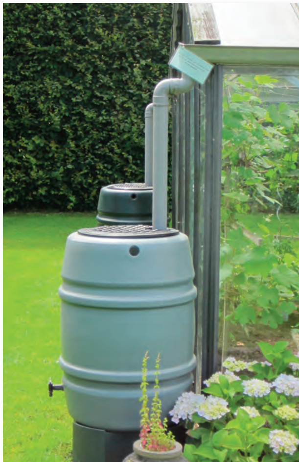
Regenwassertonnen müssen immer abgedeckt sein, damit das Wasser nicht verdunstet und Tiere nicht darin ertrinken.
