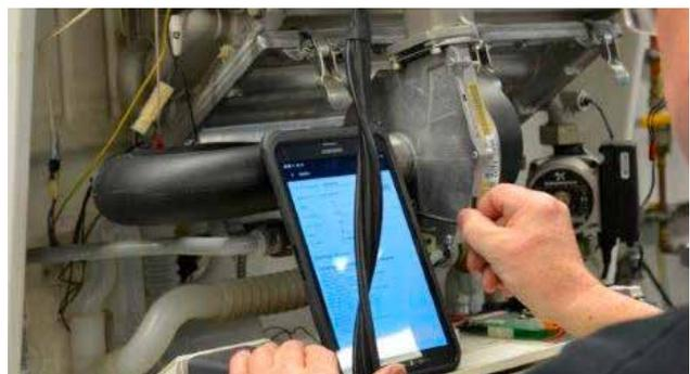
Abbildung 9: Abgasuntersuchung bei einer Qualitätsicherung
