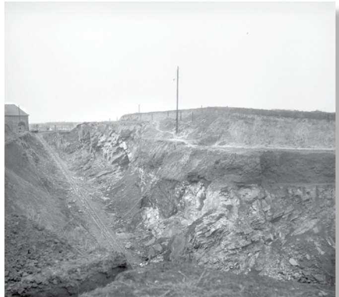
Historische Aufnahme des Steinbruchs auf dem Gelände der ehemaligen Zeche Friederike aus dem Jahr 1936
