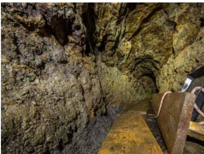
Blick in den alten Stollenverlauf (um 1755)
