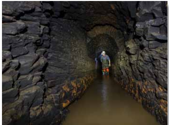
Trockensteinmauerung mit altem Wasserstand im Erbstollen
