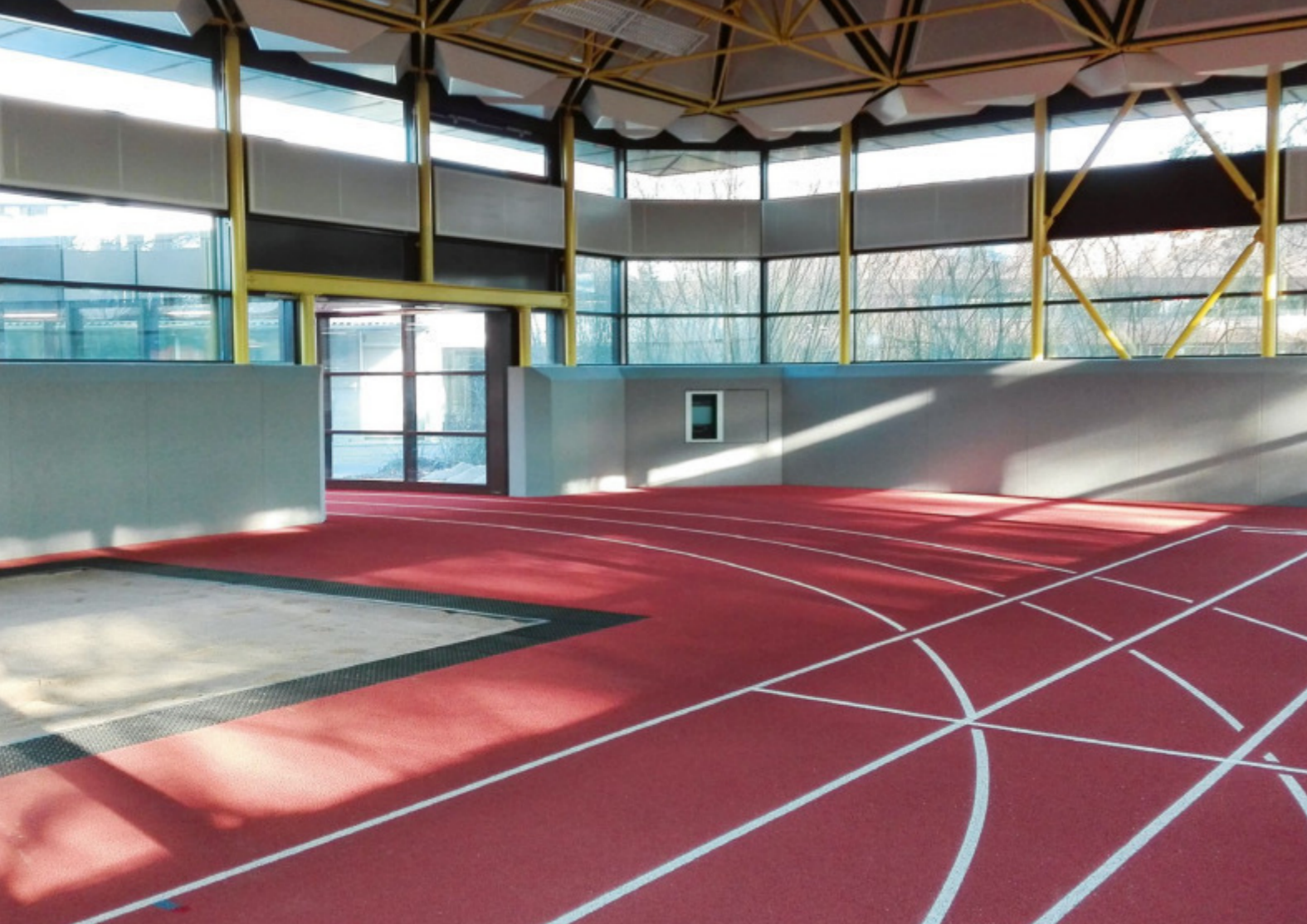
Ein Teil der Laufbahn führt durch die bestehende Halle, der andere Teil außen herum durch einen Tunnel.
