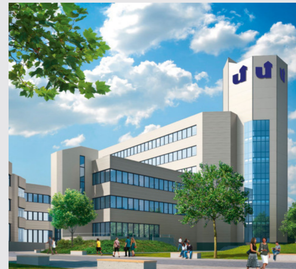
... und nach Fertigstellung
