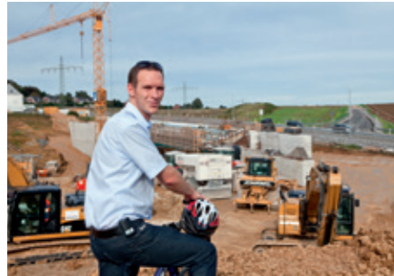
Bürgermeister Dr. Heinisch informiert sich über den Baufortschritt der A44
