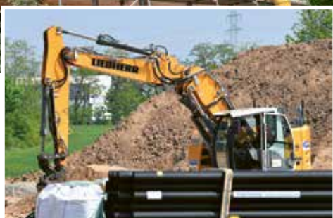
An der Nievenheimer Straße in Norf arbeiten die Bagger, um das Gelände für das neue Seniorenzentrum vorzubereiten.
