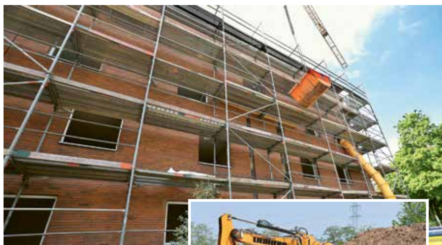
An der Josef-Wirmer-Straße werden die Gebäude kernsaniert.
