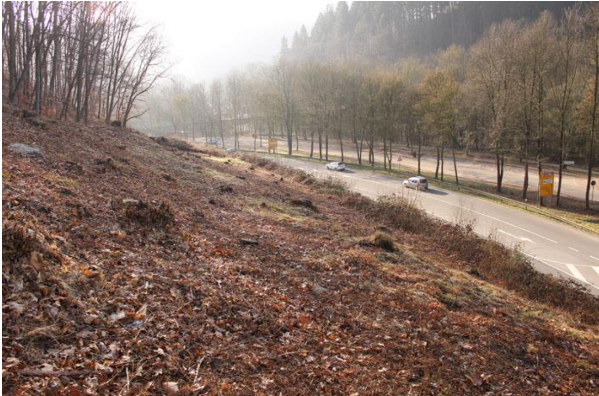
Abb. 43: Im Februar 2017 freigestellte Hangfläche an der L 74 nahe des Felssporns Müngsten (Foto vom 16.03.2017, BSMW, Boomers)
