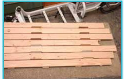
Dann werden Hilfsplatten mit dem Abstand der Streben zwischen die Unterkonstruktion gelegt.
