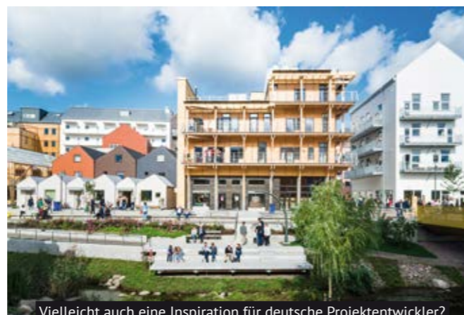
Vielleicht auch eine Inspiration für deutsche Projektentwickler? Dieses vierstöckige Pilotgebäude in Vallastaden in Linköping verwendet Holz als zentrales Baumaterial. Dabei sollen ständige Anpassungen an sich ändernde Bedürfnisse ermöglicht werden. Innenwände, Fenster und Balkontüren können mit wenig Aufwand an andere Positionen gebracht werden.
