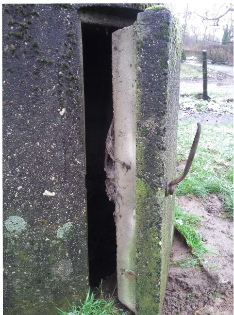
Tür der Splitterschutzzelle (SSZ), 2017. Foto: Museumsarchiv NV
