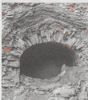
Der gemauerte Stollenzugang ist noch recht gut erhalten.
