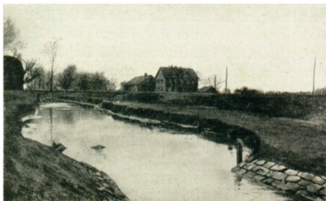
Die Berne bei Zeche Anna, vor dem Ausbau ein unregelmäßiger Schlamm Bach, nach dem Ausbau ein Abwasserkanal. Fotos aus dem Jubiläumsbuch „25 Jahre Emschergenossenschaft“ 1900 – 1925
