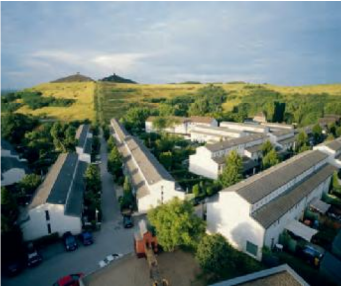
IBA-Siedlung an der Halde Rungenberg
