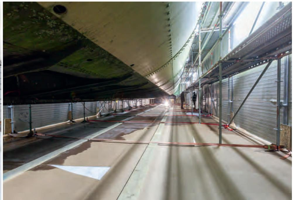
ermöglicht und zum anderen die Lärmbelästigung für AnwohnerInnen und BesucherInnen des Sees auf ein Minimum reduziert hat. An die Entschichtung der Wehrwalzen schließen sich weitere Arbeitsschritte wie die Erneuerung der Dichtungssysteme und des Korrosionsschutzes sowie Betonsanierungen an den Wehrpfeilern an. Die Arbeiten werden voraussichtlich noch bis Ende 2018 dauern.
