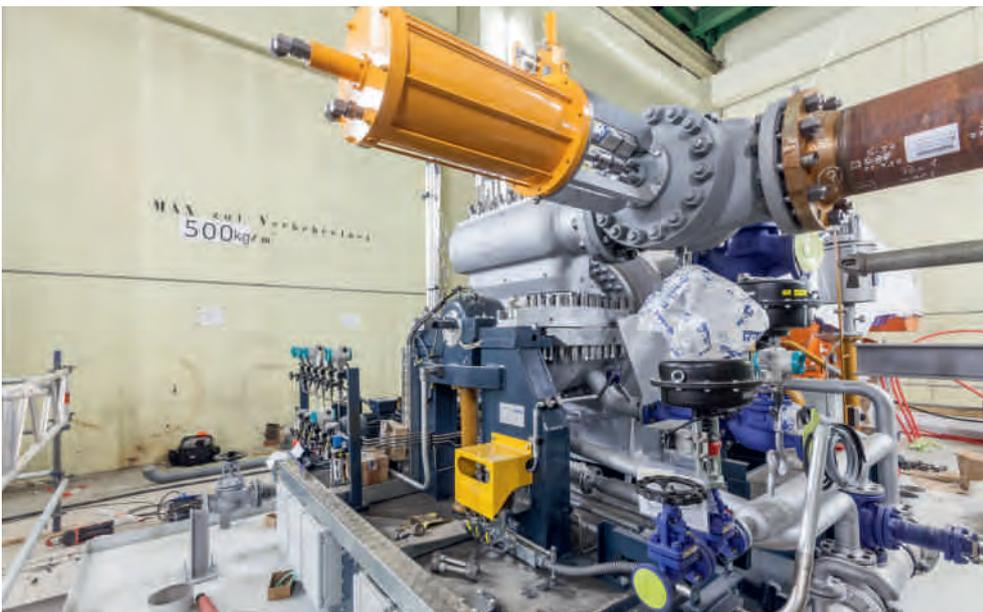
*Die neue Dampfturbine mit Generator (Bild aus der Bauphase) leistet knapp vier Megawatt. Damit kann die WFA E vollständig mit Strom versorgt werden.*
