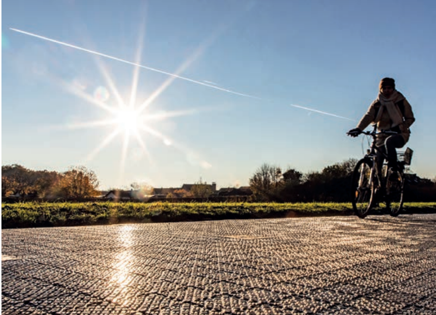
Der erste Solar-Radweg in Deutschland – in Erfstadt wurde jetzt eine 90 Meter lange Teststrecke eröffnet.
