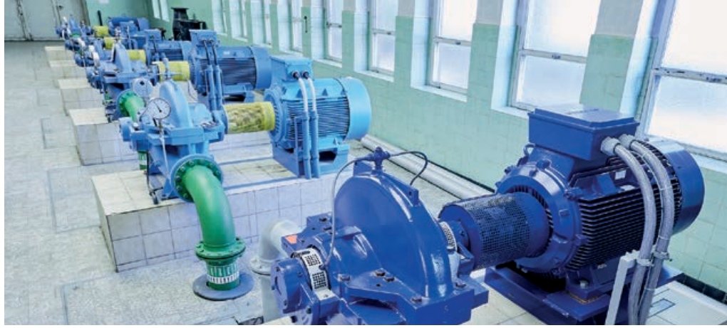
Pumpen im richtigen Moment anzusteuern – das regelt ein virtuelles Kraftwerk.
