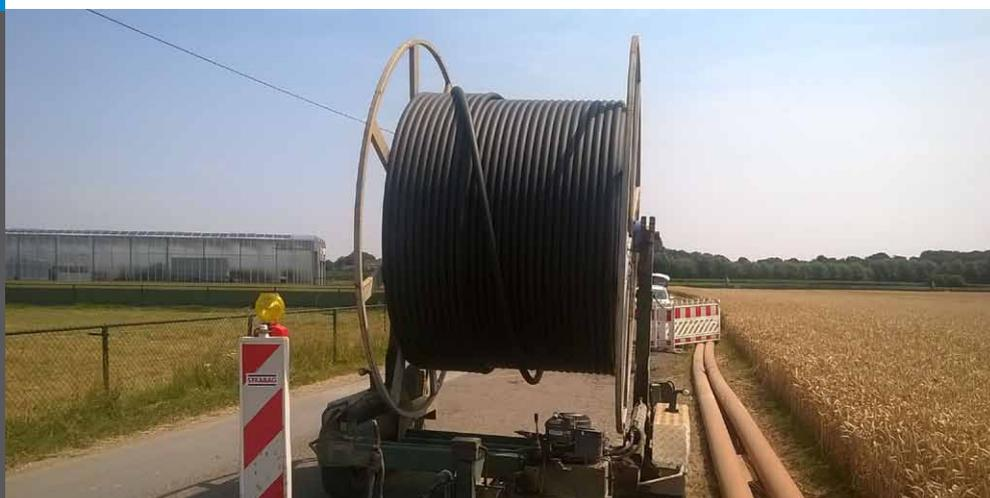
Spülbohrverfahren beim Bau der Druckleitung Wetten - Geldern
