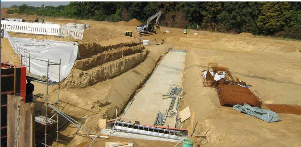
Baugrube des Retentionsbodenfilters auf der Betriebsstelle Jackerath
