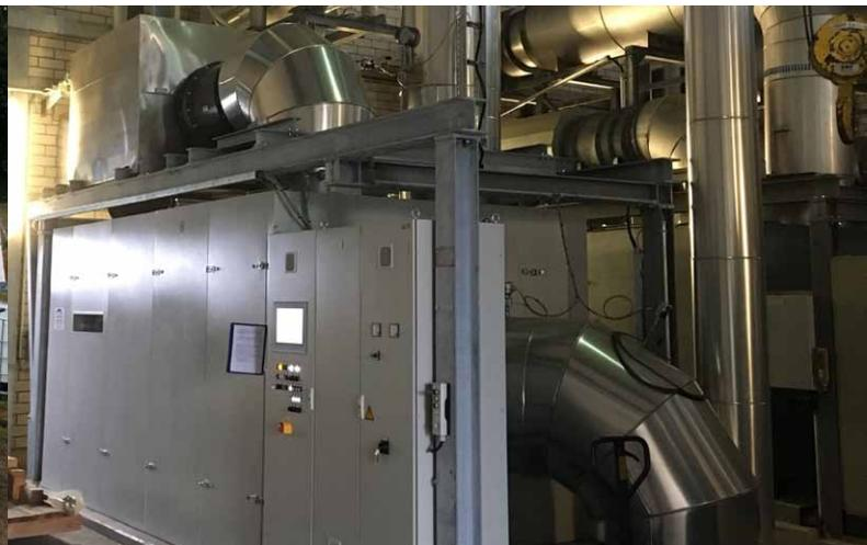
Turbogebläse 6 (PGW 6) in Schallschutzhaube
