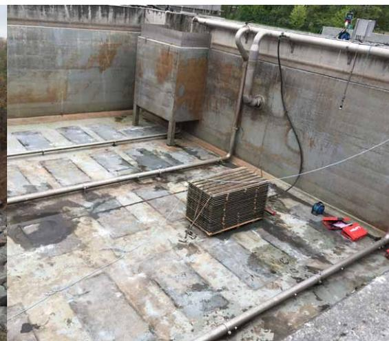
Entleertes Becken A mit rückgebauten alten Plattenbelüftern auf der Kläranlage Herongen
