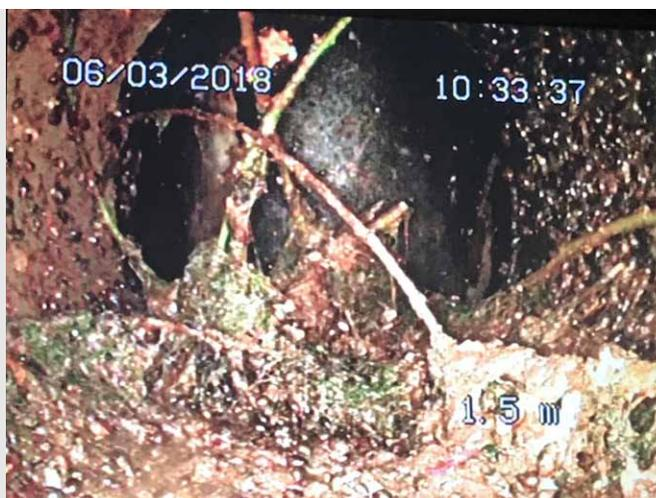
Kamerabefahrung der Filter-Verteilerarme auf der Kläranlage Goch: Ablagerungen durch Äste, Blätter und Algen
