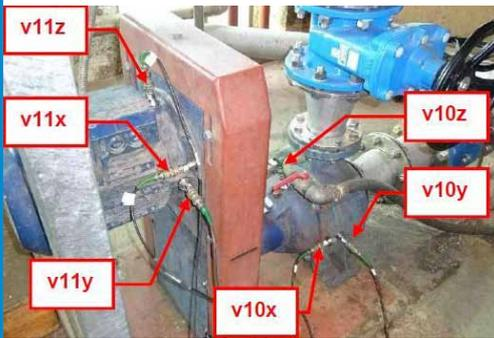
Schwingungssensoren an Pumpe in drei Achsenrichtungen (X,Y,Z)
