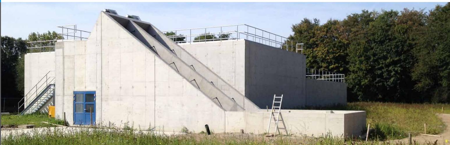
Neu erbaute Flockungsfiltrationsanlage auf der Kläranlage Dülken
