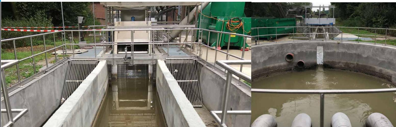
Betriebsstelle Viersen - Sanierter Zulaufbereich in und gegen Fließrichtung
