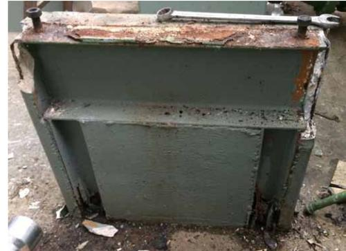
Abbruch des alten Fundaments der Beschickungspumpe auf der Kläranlage Grefrath
