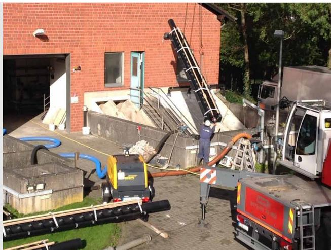
Einbau der neuen Schnecken auf der Kläranlage Brüggen
