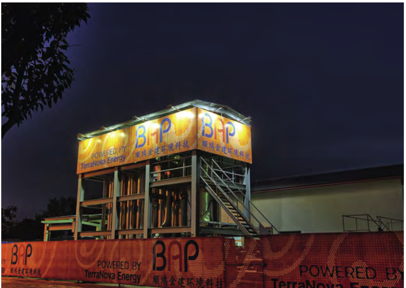
Die Düsseldorfer TerraNova Energy GmbH entwickelt ein Verfahren zur Gewinnung von Phosphor und Brennstoff aus Klärschlamm. Hier die Pilotanlage in der chinesischen Millionenstadt Jining.
