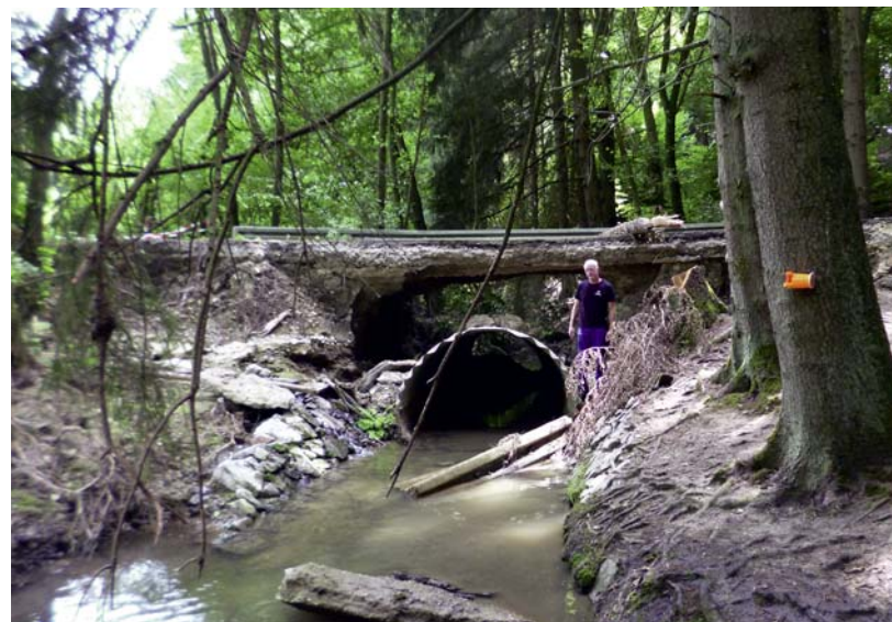
Freigespülte Verrohrung unter einer Straße am Weltersbach
