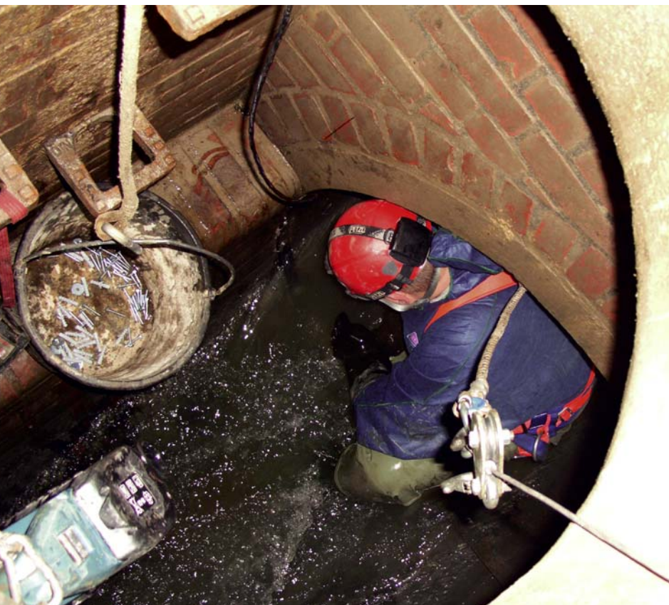
Einbau von Messeinrichtungen im Kanal
