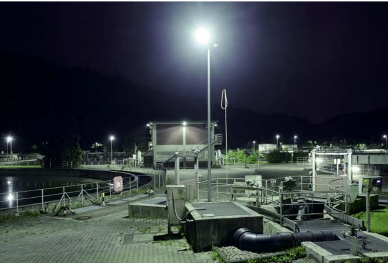
Kläranlage Buchenhofen, LED-Beleuchtung
