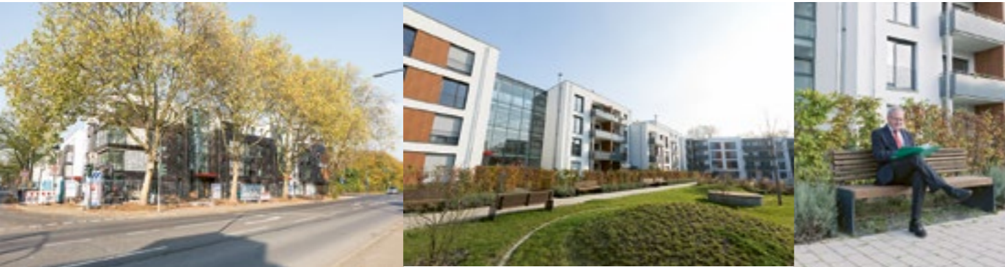
Mit der Klimaschutzsiedlung Am Wald hat Jürgen Heddergott von der SWD Wohnraum für alle Generationen geschaffen.
