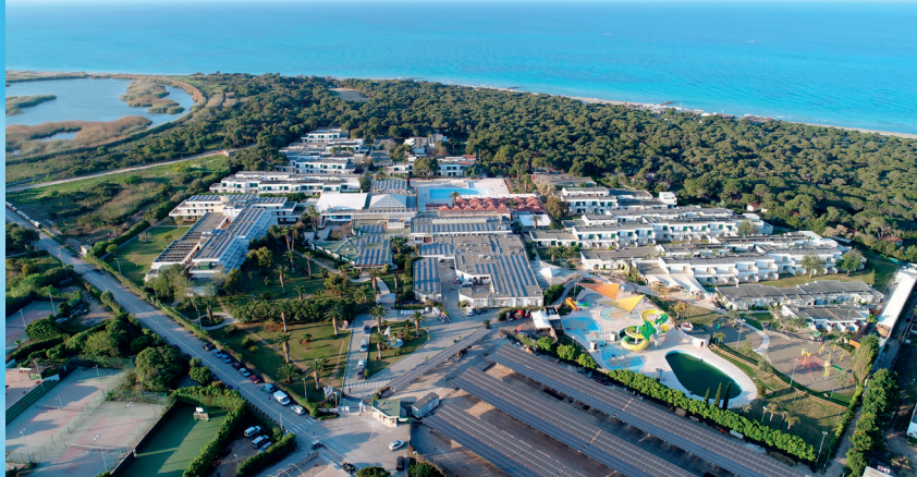
Auf den Dächern des ROBINSON Clubs Apulia in Italien wandeln Photovoltaikanlagen Sonnenlicht in elektrische Energie.
