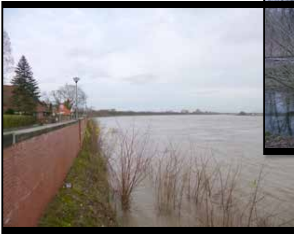
8. Januar: Hochwasser – Neusser Pegel bei 9,04 Metern
