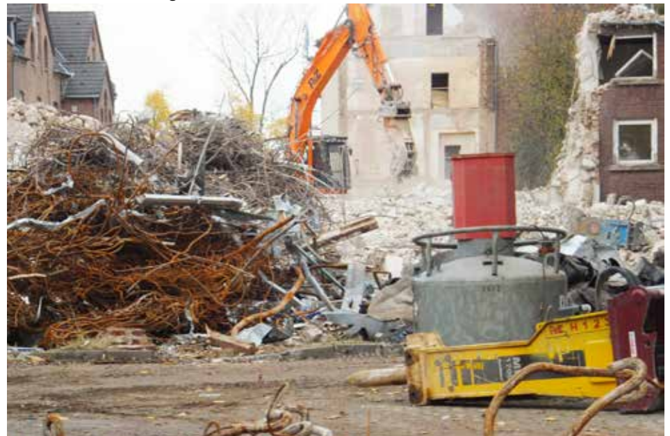
Abriss im Alexianergelände
