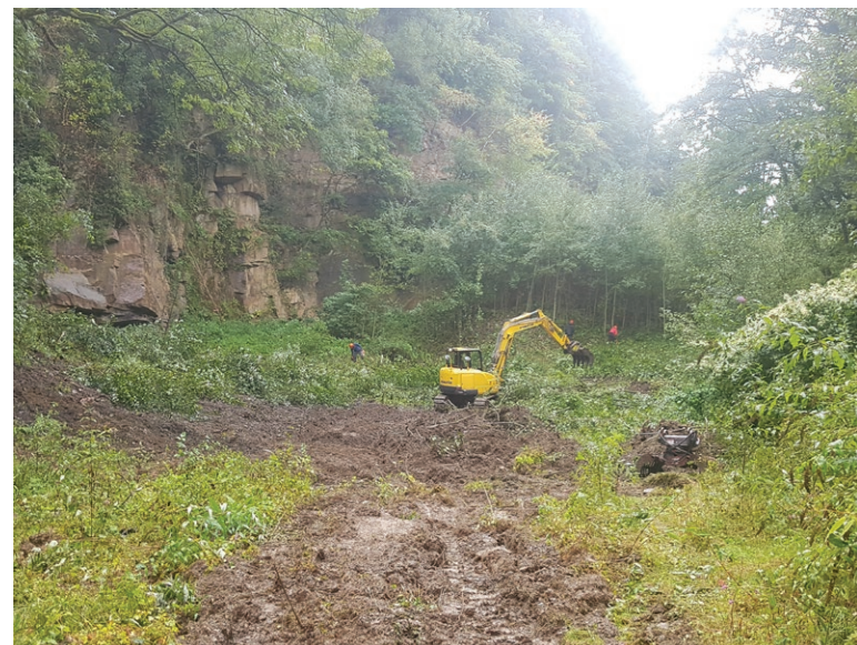
Abbildung 139: Rodungsarbeiten im Steinbruch Laupendahler Straße
