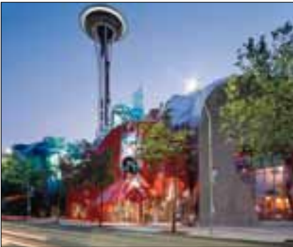
Abb 35: Das neue Gebäude des Experience Music Project (EMP) und die Space Needle von 1962
