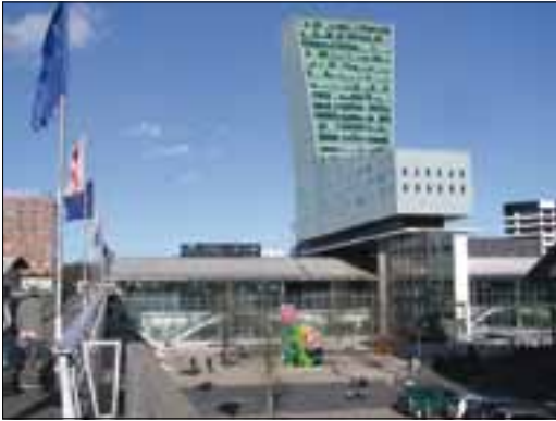
Abb 21: Das Büro- und Dienstleistungszentrum Euralille
