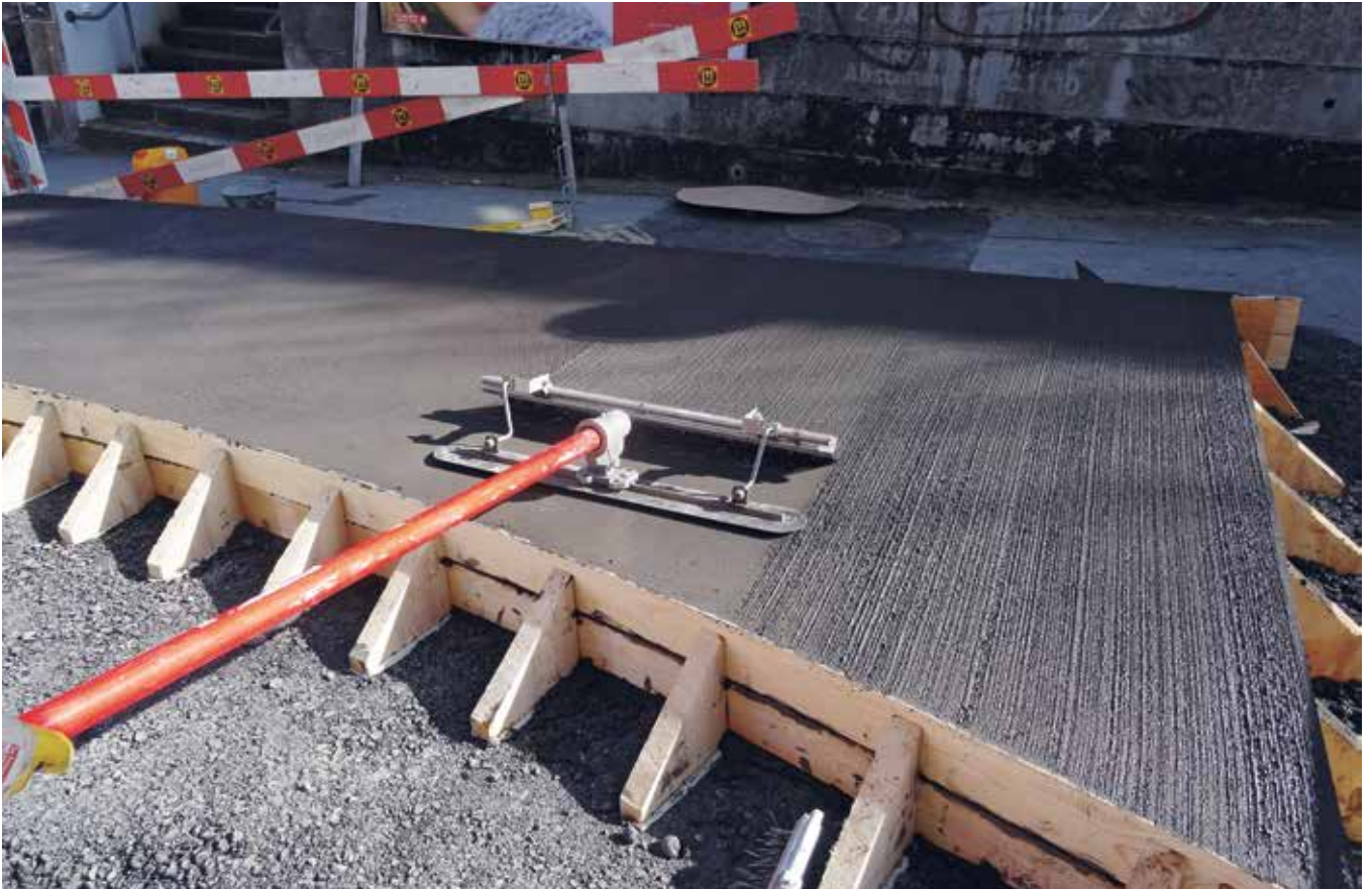
Aufrauen der Oberfläche mit dem Besen (oben) und Verkehrsinsel mit geklebten Randabschlusssteinen (rechts).
