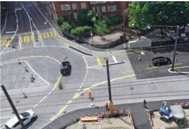
Der neu gestaltete und in jeder Hinsicht sanierte Eigerplatz mit seinen robusten und langlebigen Fahrbahnen aus Beton.
