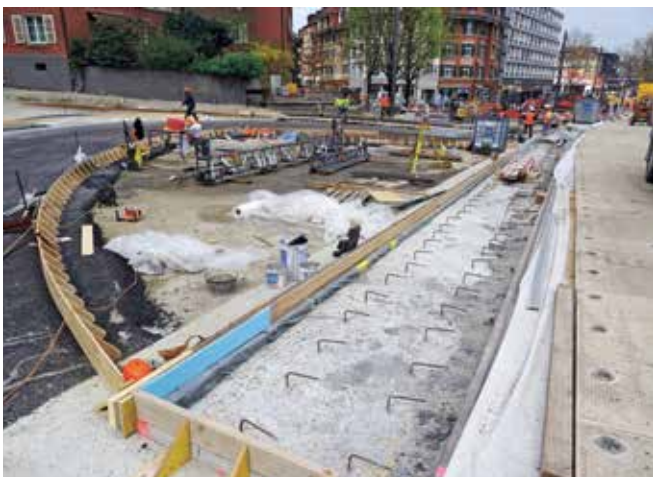
Betonieren der Randstreifen des Gleisbaus im Verbund.
