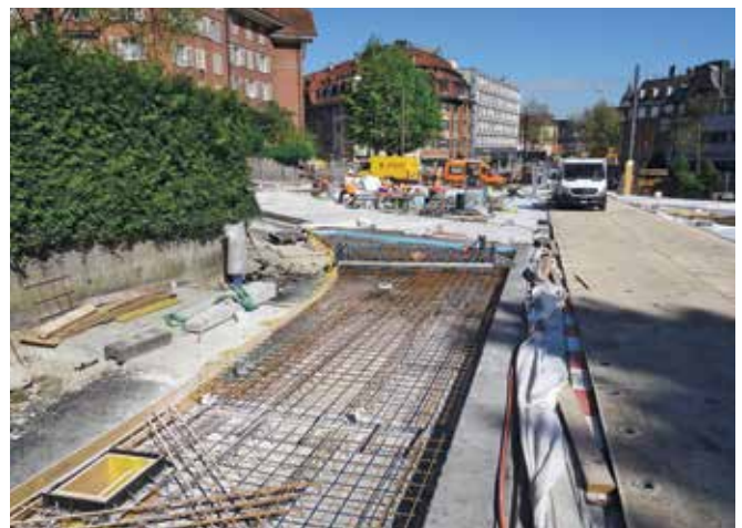
Betonierarbeiten der dritten Etappe.
