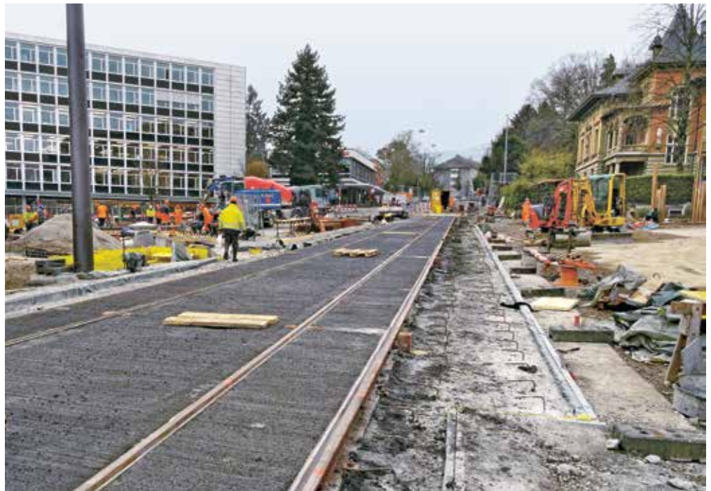
Fertige Tramtrasse vor dem Betonieren des Betonkreisels.
