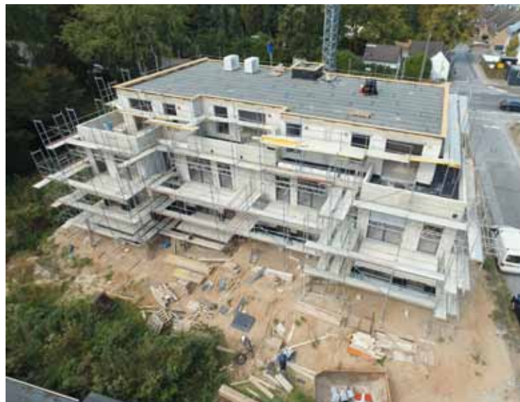
Eines der aktuellen Projekte im Sozialen Wohnungsbau in Langenfeld wird Am Brüngersbroich realisiert.
