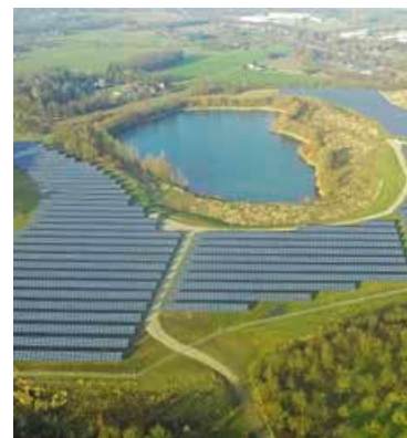
Der ENNI Solarpark Mühlenfeld ist einer der Veranstaltungsorte des Türöffner-Tags der Maus.
