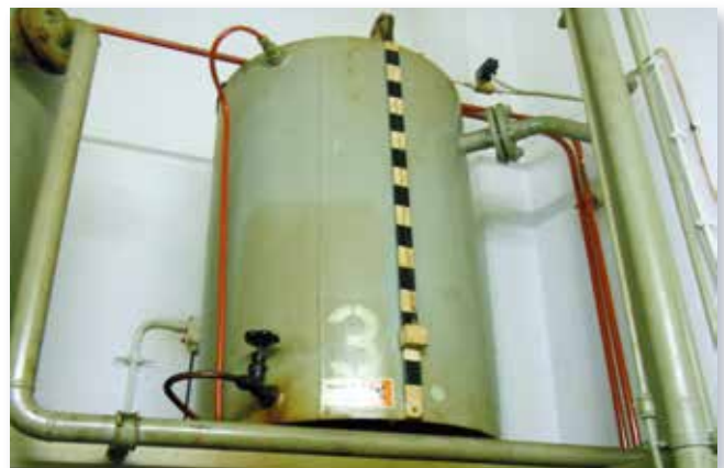
alte Heizölverbrauchsanlage Sonderbauwerke
