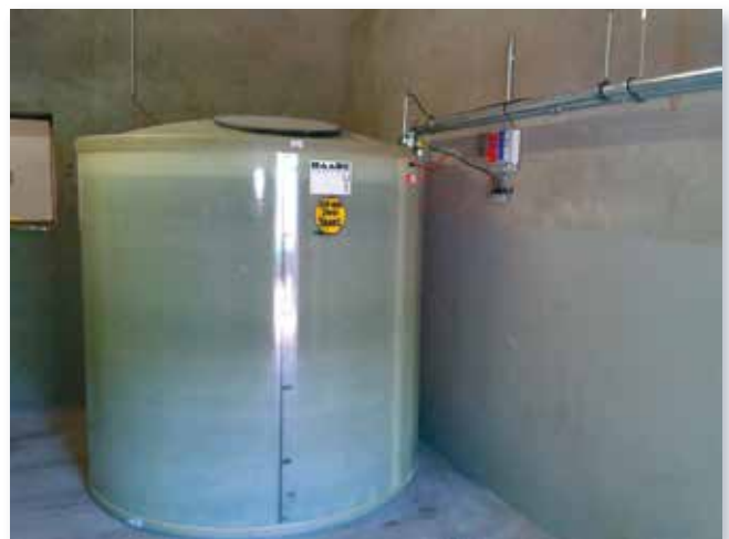
neue Heizölverbrauchsanlage
