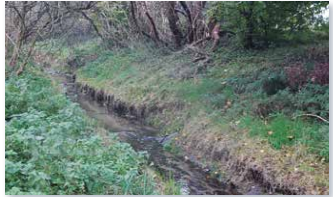
vor der Maßnahme
