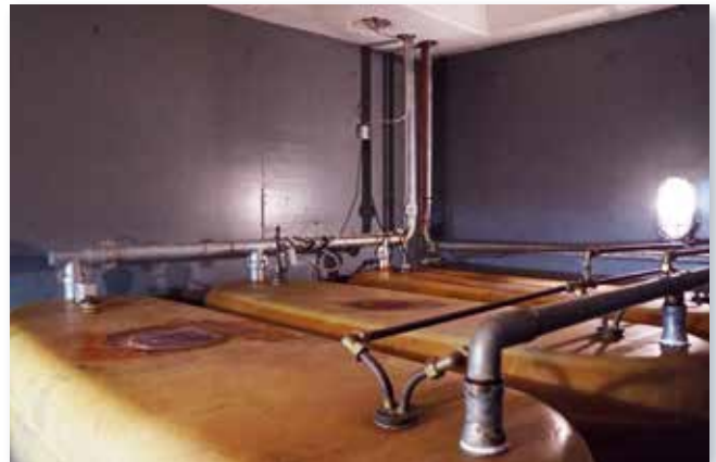
alte Heizölverbrauchsanlage Sonderbauwerke
