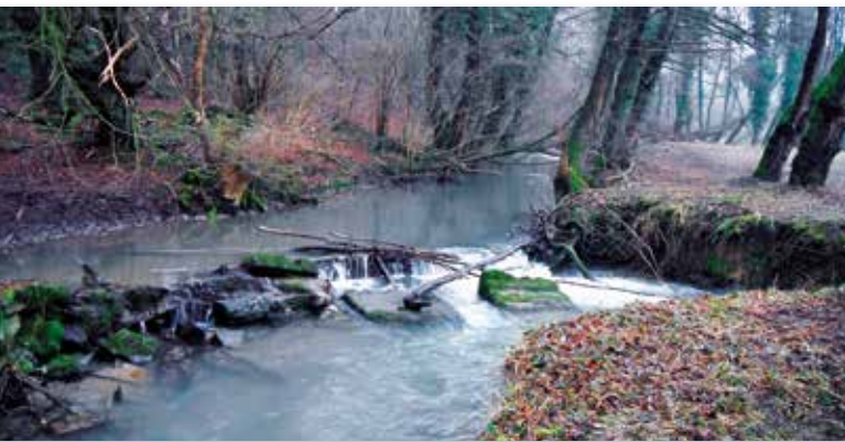
Wehranlage Ellensiepen vor der Maßnahme
