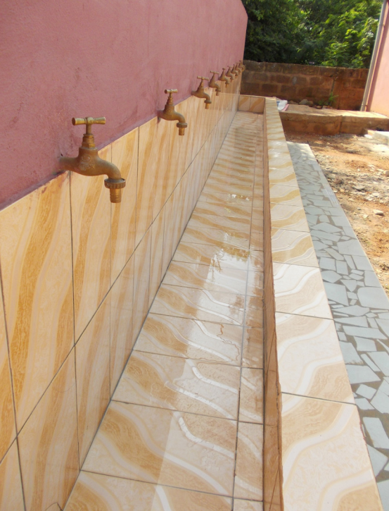
Auf dem Schulgelände wurden Toiletten mit fließendem Wasser und einer Handwaschanlage installiert sowie ein medizinisches Zentrum eingerichtet.
