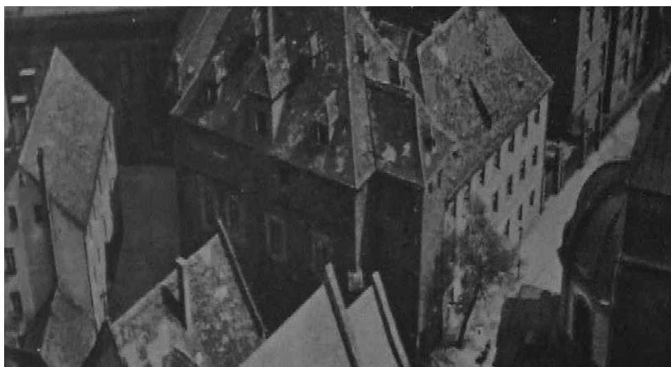
Blick auf die Ostseite des Diözesanarchivs, in: Die katholische Welt , Foto-Beilage zum katholischen Sonntagsblatt der Erzdiözese Breslau vom 23. Juli 1939
