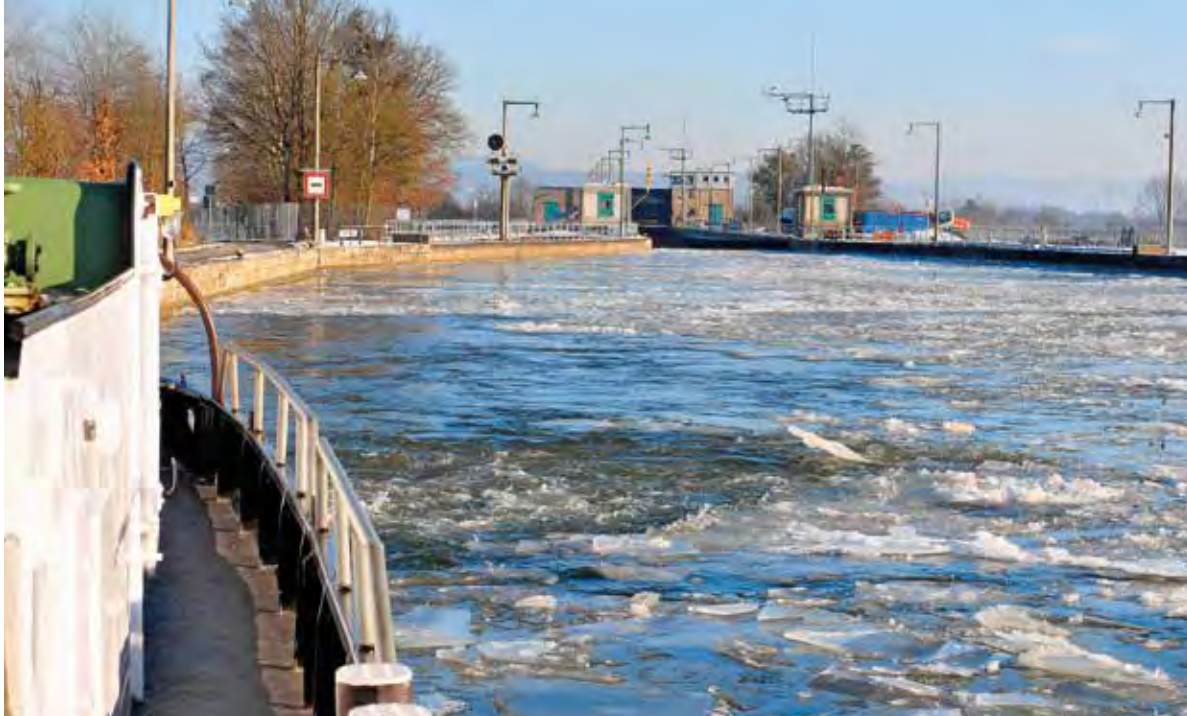
Eisscholle voraus! Dauerfrost brachte am Monatsende die Schifffahrt auf der gesamten Länge des Main-Donau-Kanals zum Erliegen, nachdem selbst Eisbrecher wie die Angermünde vor der sich stetig ausbreitenden und immer dicker werdenden Eisschicht kapitulieren mussten. (Quelle: Nordbayerische Nachrichten/Roland Huber)
